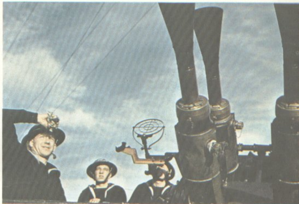
Tipizirani četvorocijevni 40 mm brzometni protuavionski topovi kojima su bili opremljeni britanski ratni brodovi.
