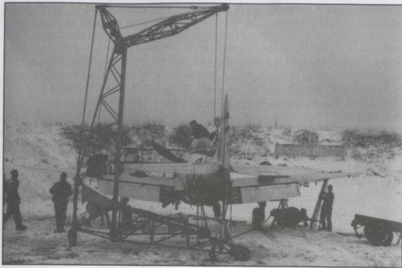
Reglaža mitraljeza kalibra 12,7mm na avionu F-47D Tanderbolt u zimu 1952-1953. godine.
