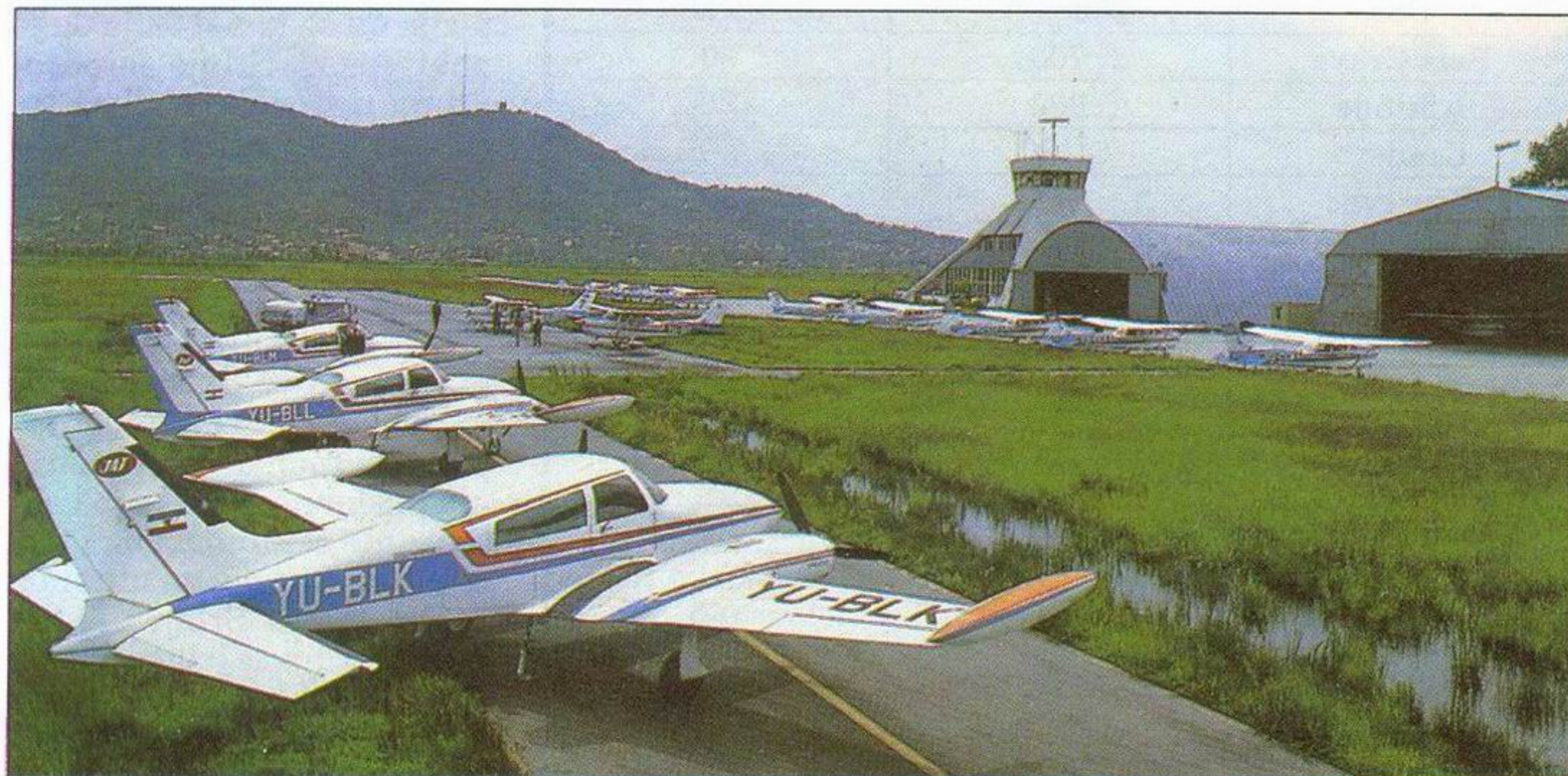
Aerodrom u Vršcu, jedan od najmodernijih u Srbiji. Posедуje svu neophodnu opremu potrebnu za školovanje pilota. Na slici je stajanka sa avionima iz JAT-ove letačke škole
