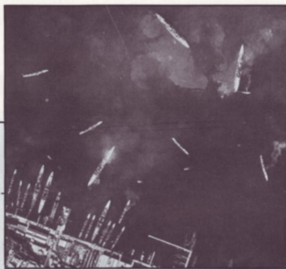
Levo: Oštećene krstarice u unutrašnjoj luci Taranta, jedan dan posle napada.
