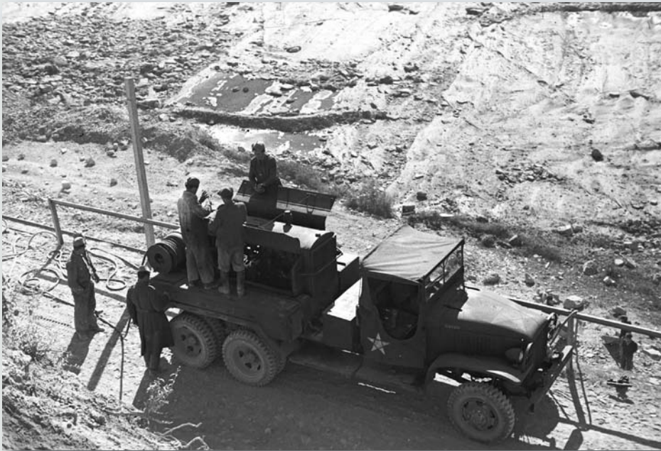
Инжињерија Југословенске армије у градњи железничке пруге Зеница–Лашва са покрећном компресорском станицом Л'Роа 210 Г-2 примљеном преко помоћи UNRRA (Фото-центар „Одбрана“)
