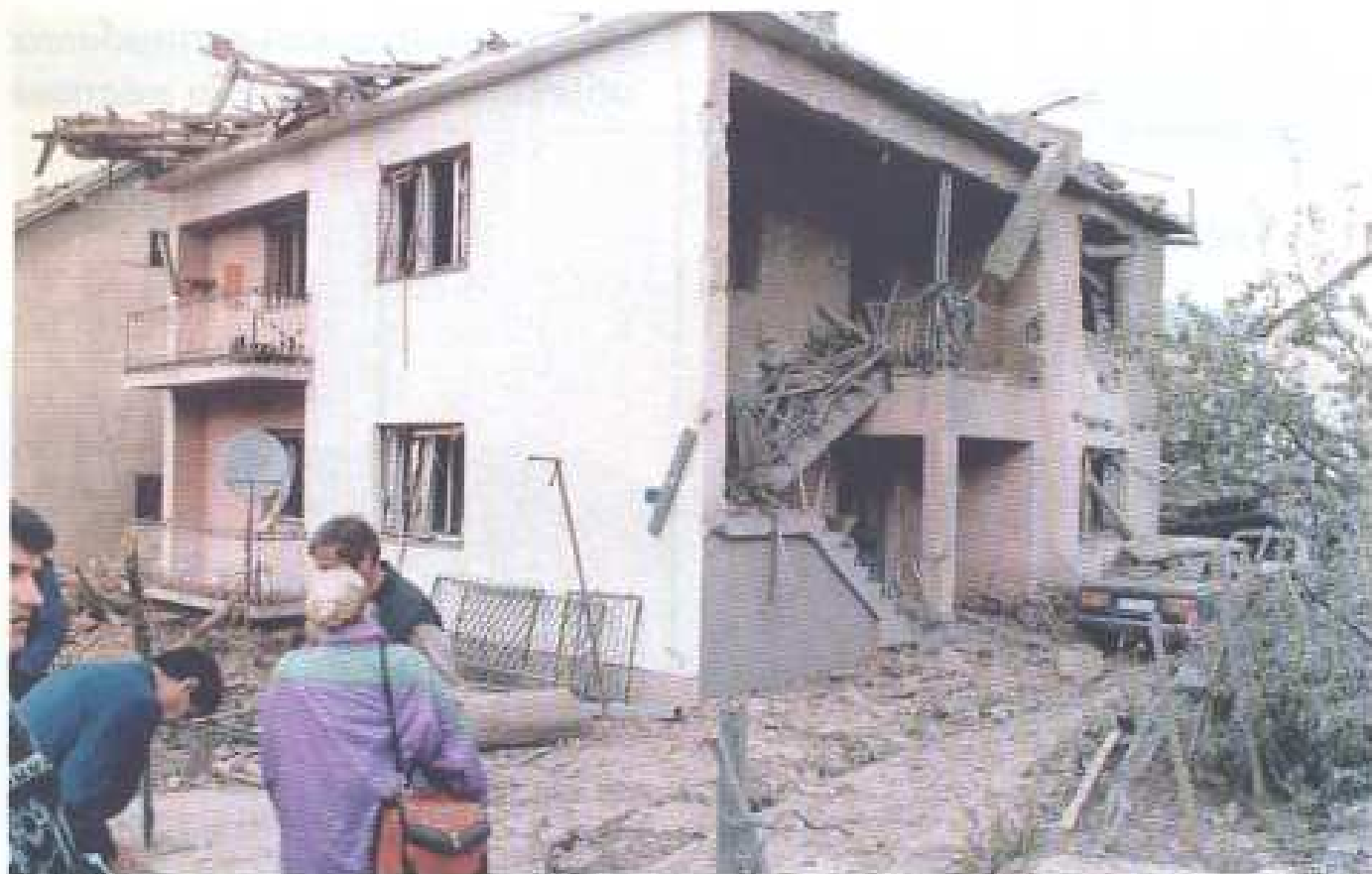
Слика 3 Ближи изглед оштећене куће Драгана Стефановића, у непосредној близини места пада пројектила
