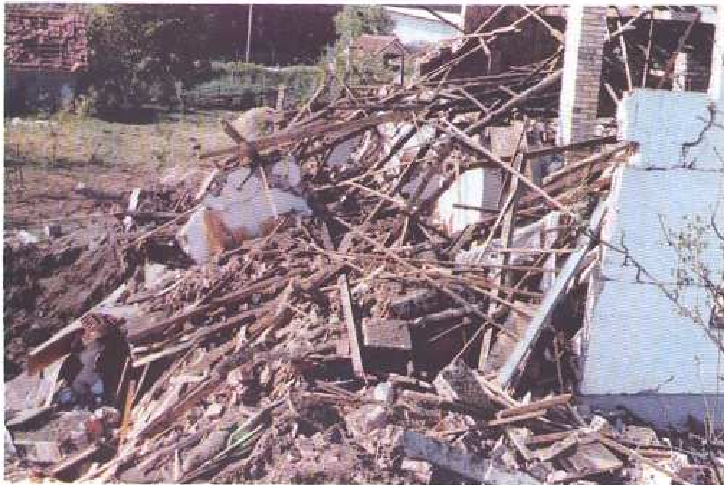
Слика 104 Срушена кућа и помоћне зграде власништво Бараћ Верослава, ул. Михаила Пупина бб у Новопазарској Бањи, где су тешко повређени супруга Бараћ Олга и ћерке Милица и Дијана – дана 25. 05. 1999. године (у Новопазарској Бањи оштећено је још тридесетак кућа)
