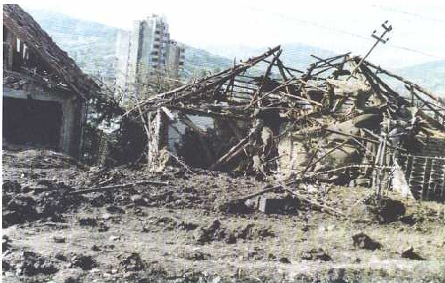
Слика 152 Ближи изглед срушене куће Филиповић Рада из Новог Пазара, ул. М. Јовановића, 1. 05. 1999. године
