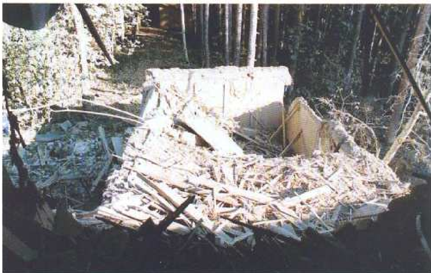
Слика 14 Изглед једног од потпуно уништених павиљона. У срушеној згради „Санаторијума“ погинуло је 19, а повређено 38 лица.
