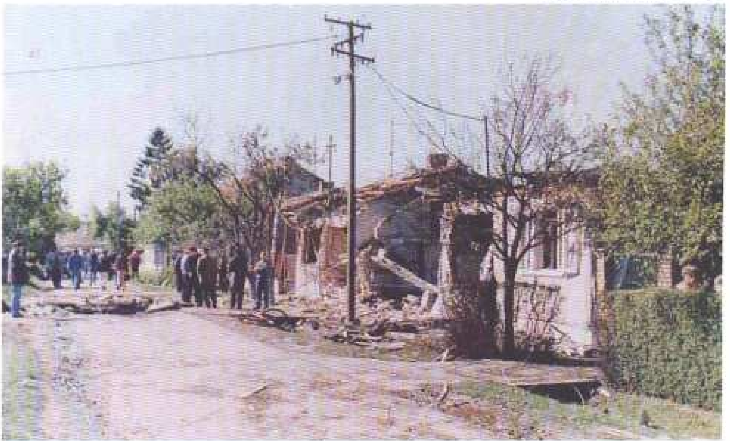
Слика 95 Порушене куће у ул. Вука Караџића у Сомбору, где је погинуло једно, а повређено више лица. Срушено је и оштећено око 50 кућа, дана 21. 05. 1999. године.
